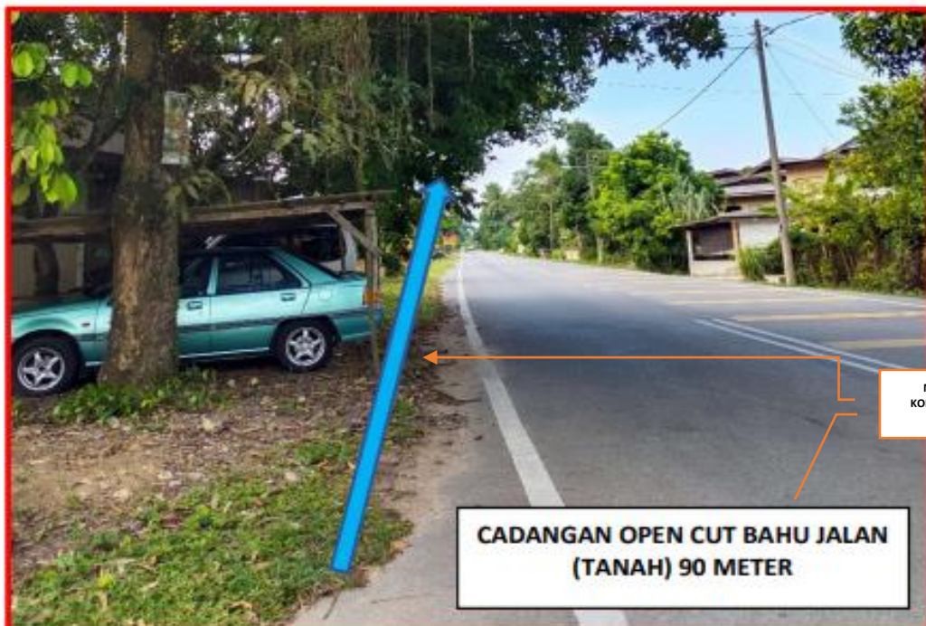
GAMBAR 4 : KAWASAN KERJA MELIBATKAN PEMOTONGAN BAHU JALAN (TIDAK BERTAR)
