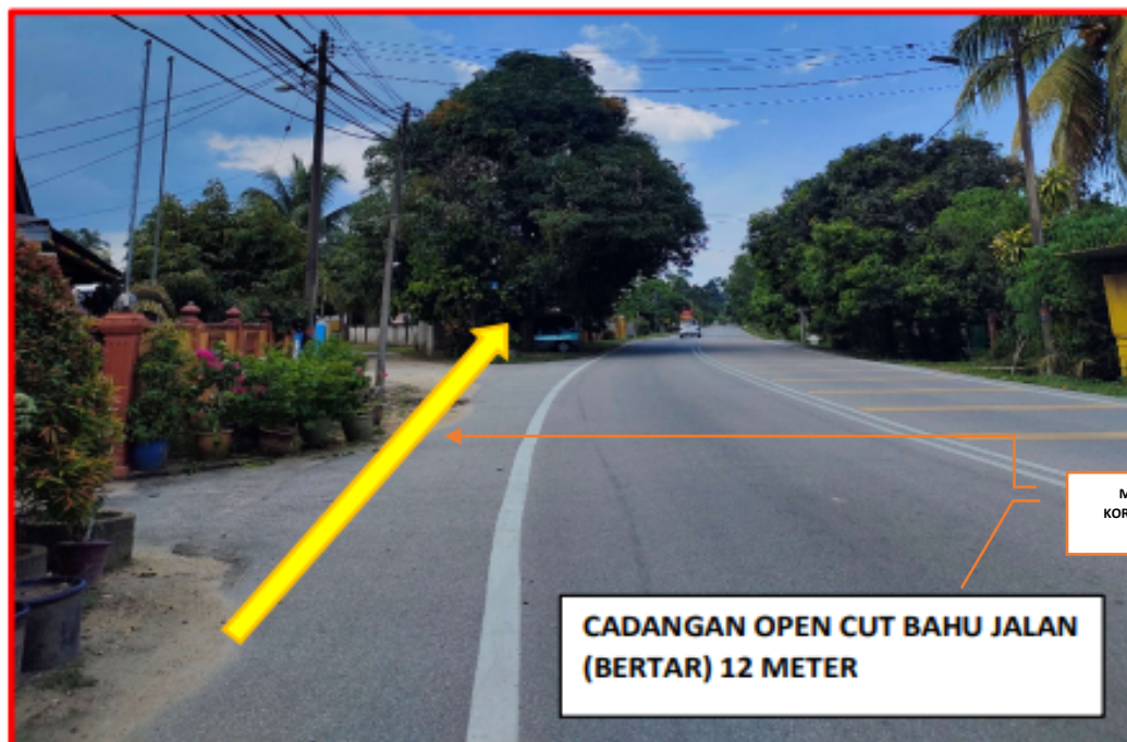
GAMBAR 3 : KAWASAN KERJA MELIBATKAN PEMOTONGAN BAHU JALAN (BERTAR)
